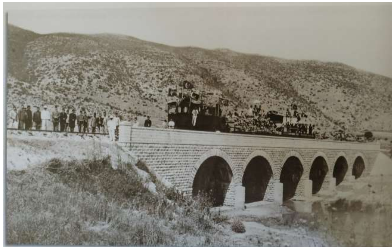
גשר הרכבת העותמאני על נחל הקישון, בטקס חנוכתו ב-1903.
